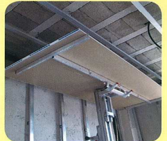
Montaje de paneles de pladur. Installing plasterboard panels.
