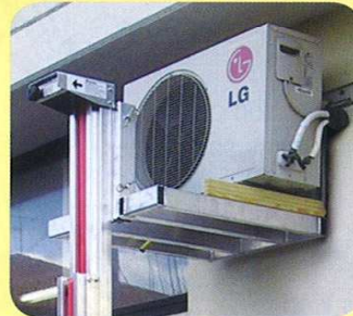
Montaje de aire acondicionado. Installing air-conditioning systems.
